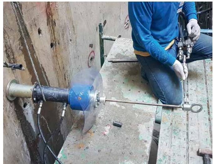
Mit dem Ziegerät PullDevice H-1 ist das horizontale Ziehen von Rammverpresslanzen problemlos möglich.
